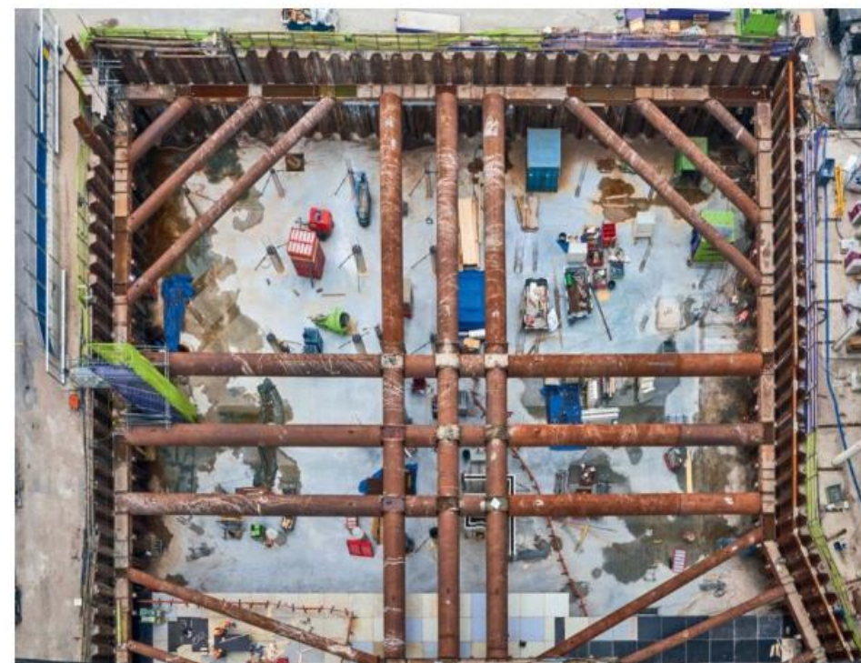
Figuur 6 - Kruisende stempelbuizen vanuit de lucht.
